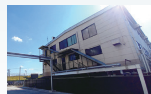
隣接企業へ蒸気供給ライン
