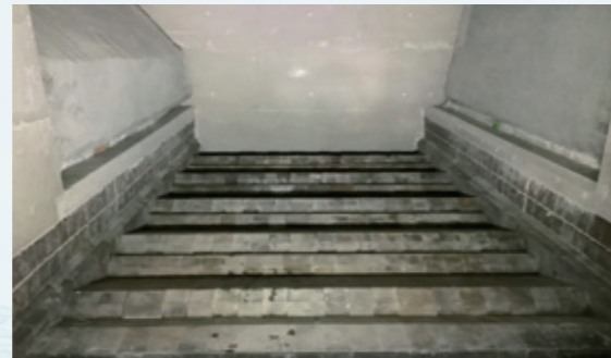
後燃焼ストーカ・再燃焼室
